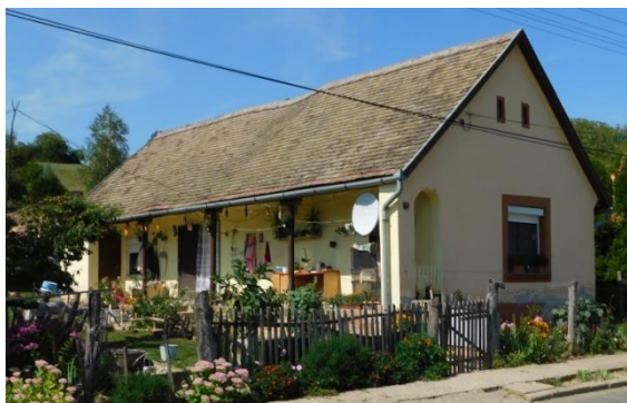
Fő u. 10. Lakóépület, nyitott faoszlopos verandával. A melléképület nyílásait részben befalazták, illetve átalakították. A melléképület felújítása során az eredeti nyílásméretetek visszaállítása javasolt. Védendő az épületek tömege .
